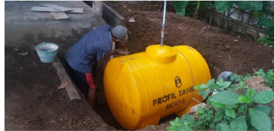
■ Pemasangan tangki biogas berkapasitas 1.100 liter.
