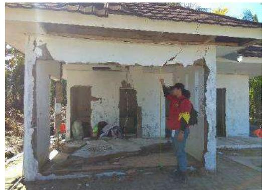
Pengukuran Ketinggian Air Tsunami
